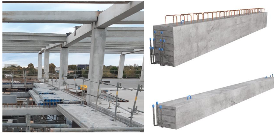
Figure 1.9. Structure en béton précontraint (Poteau-Poutre)
