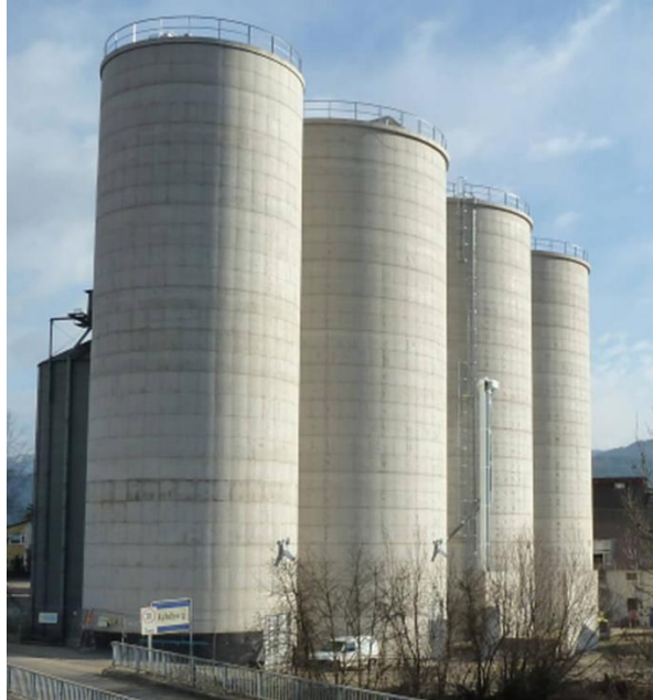
Figure 1.14. Silos en béton précontraint
