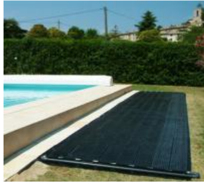
Photo : Panneau solaire pour le chauffage de piscine
