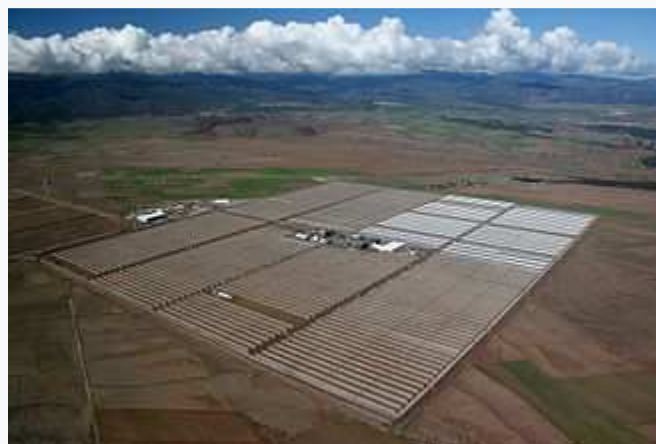
Centrale solaire d'Andasol (Espagne), cette centrale solaire utilise la technologie de stockage de chaleur dans des réservoirs de sel fondu, pour produire de l'électricité la nuit ou le jour quand le soleil ne brille pas.
