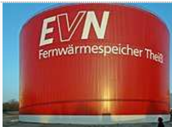
Stockage thermique à Krems en Autriche, 50 000 m 3 d'eau, 2 GWh.
