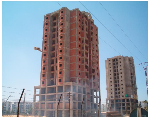
Figure 2.7. Contreventement mixte d'un bâtiment.
