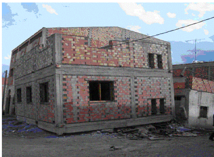
Figure 2.5. Contreventement par maçonnerie.
