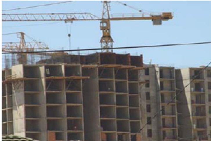
Figure 2.3. Contreventement par voiles en béton armé.
