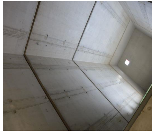
(b). Cage d'ascenseur en béton armé.
