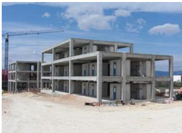
Figure 2.1. Ossature en portiques en béton armé.
