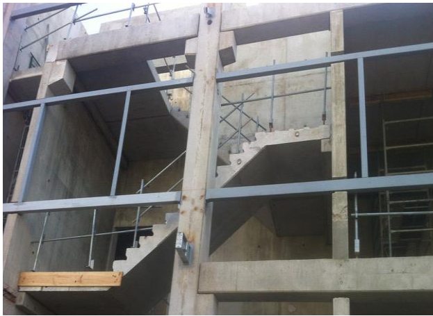
(a). Cage d'escalier en béton armé.
