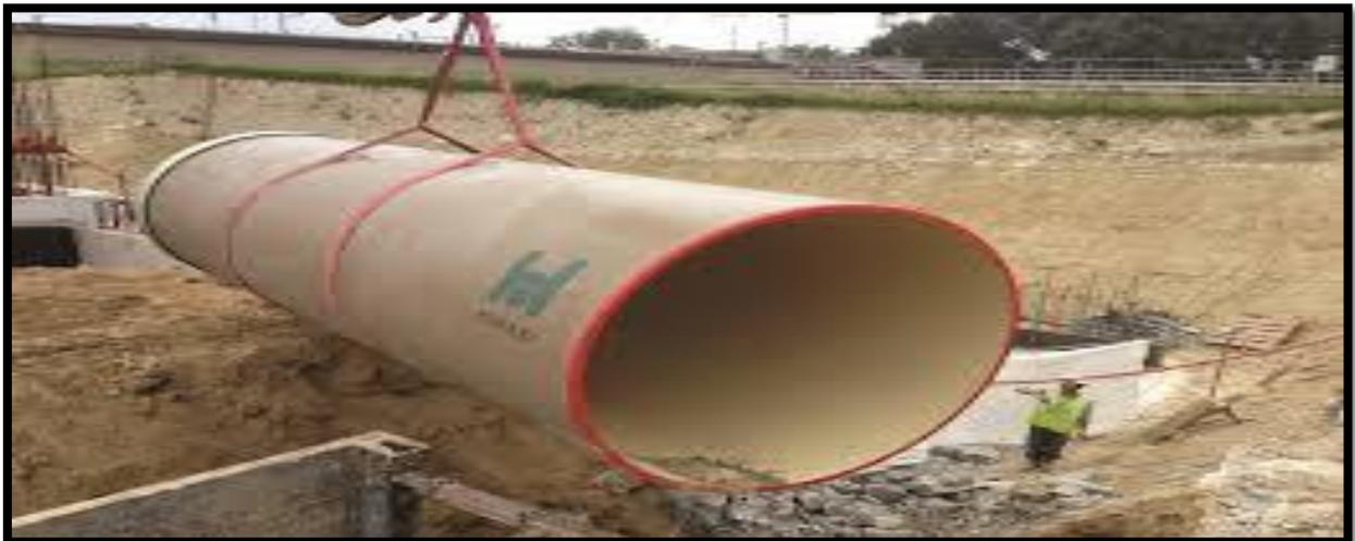
**Figure 9 :** Tuyau en PRV
