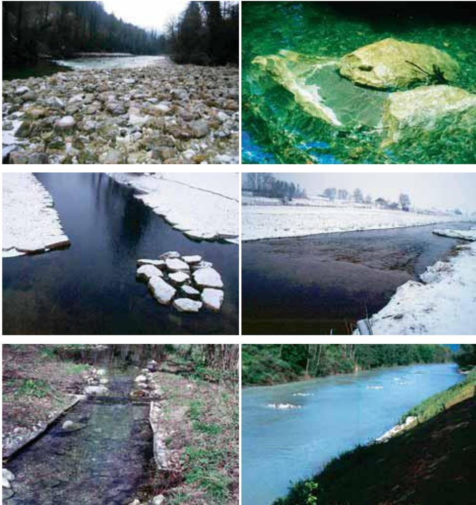
**Figure 1 :** Différents exemples d'aménagements essentiellement piscicoles : en haut à gauche risberme en enrochements sur la Bienne (39), en haut à droite agencement de blocs sur la Savoureuse (90), au centre amas de blocs et radier artificiel sur le Drugeon (25), en bas à gauche caches artificielles sur un petit ruisseau affluent de l'Allondon (Suisse, canton de Genève) et en bas à droite aménagements piscicoles sur l'Arve (74)
