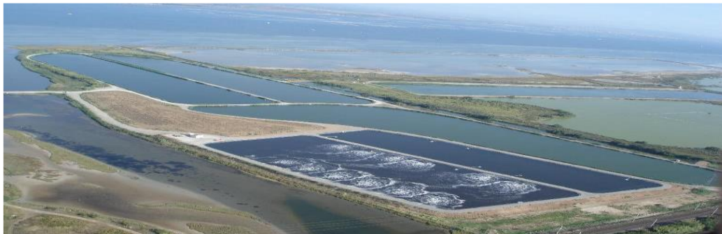
Figure 4: Photo de bassins de lagunage aéré.
