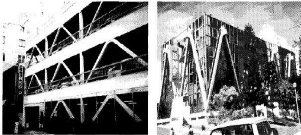
**Figure 4.17 :** Façade formant des éléments de contreventement [13].
