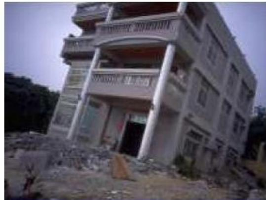
**Figure 4.2 :** Immeuble sur faille Séisme de Chi-Chi (Taïwan 1999) [13].
