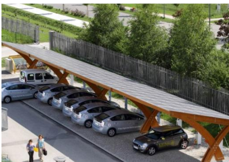
Parking solaire pour véhicules Electriques
