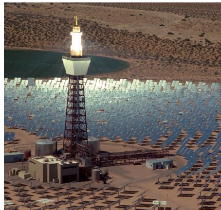
Récepteur à cavité d'une tour solaire
