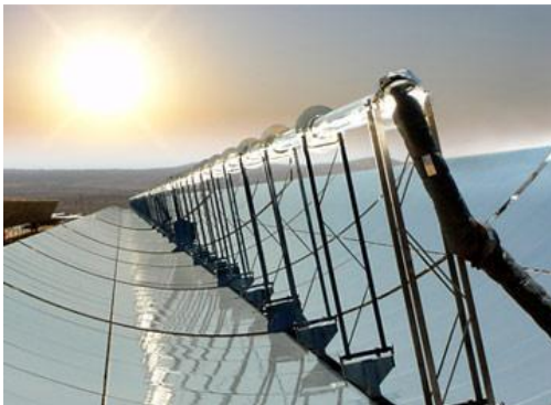
Centrale solaire à collecteurs cylindro-paraboliques
