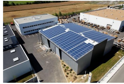
Panneaux photovoltaïques en toiture d'entrepôt
