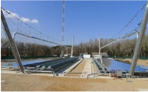
Centrale solaire à collecteurs de Fresnel
