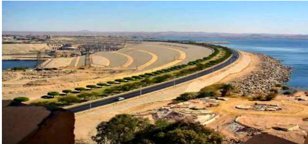
Figure 6 : Le barrage d'Assouan, en Egypte.
