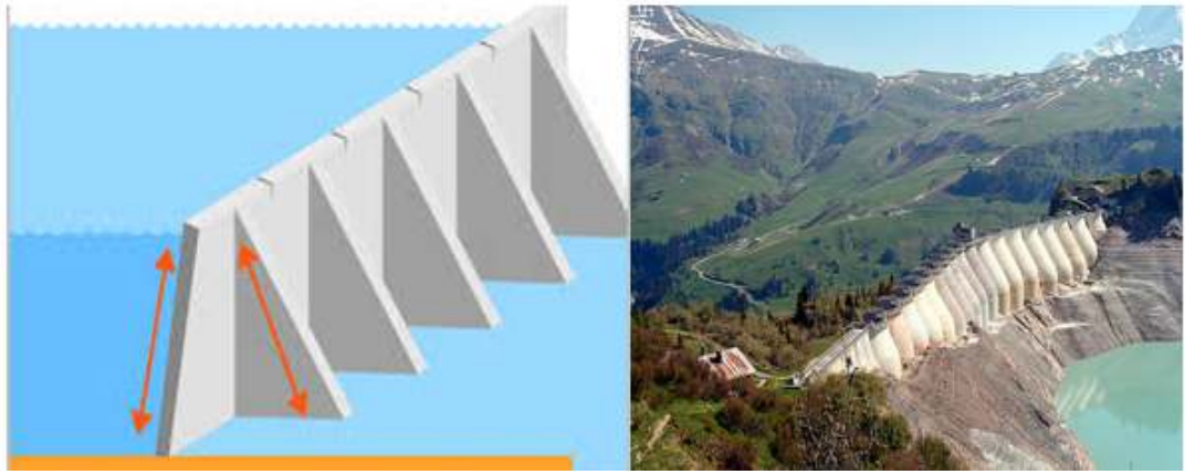
Figure 5 : Le barrage de la Girotonne, en Savoie.
