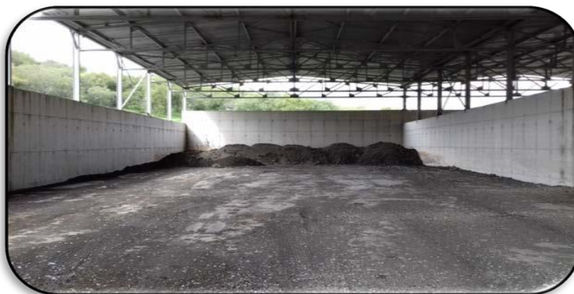
Stockage des boues
