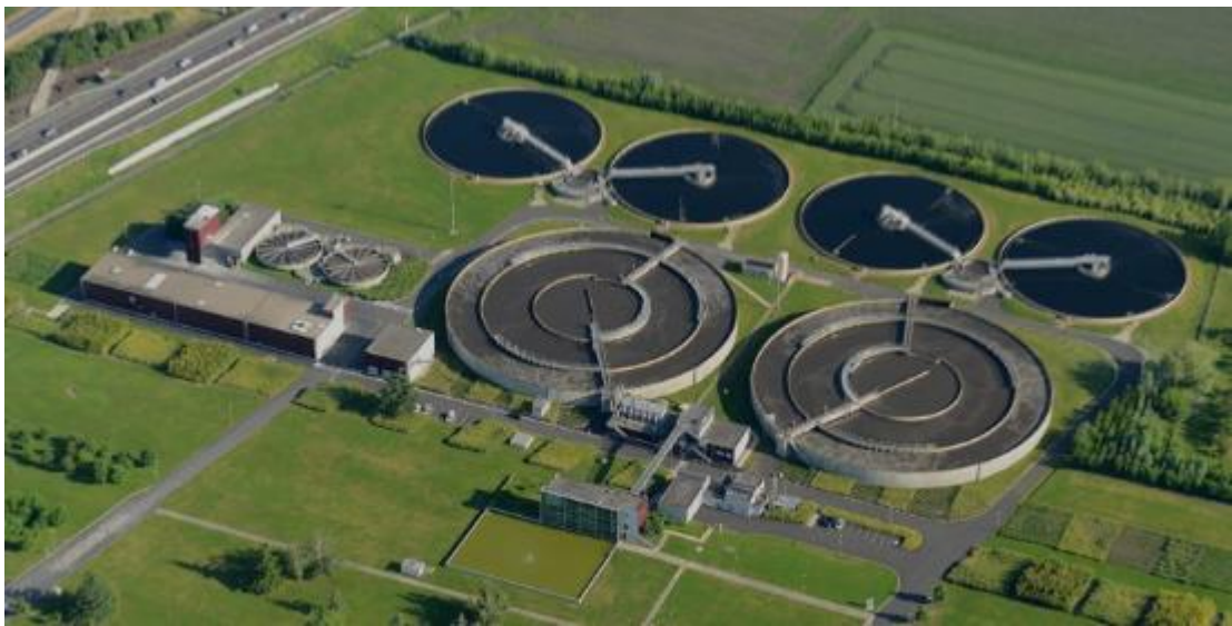
Vue aérienne d'une station d'épuration.
