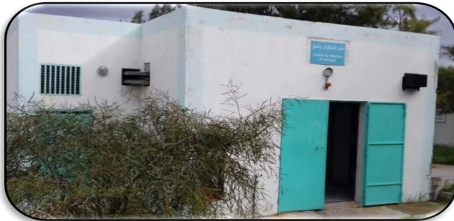
Poste de relevage
