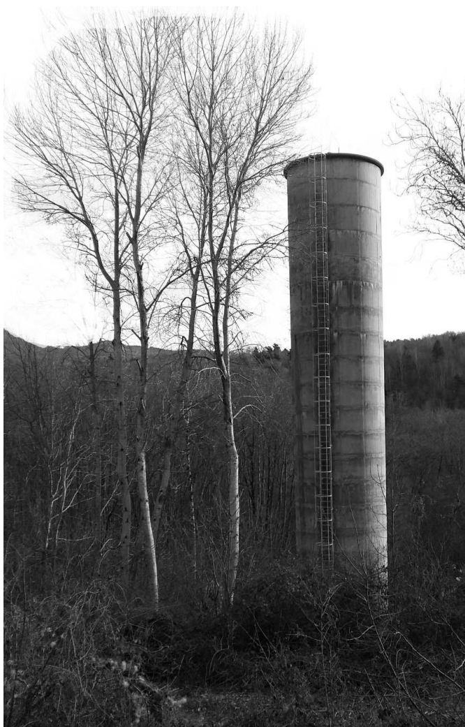
FIGURE 3.12 Cheminée d'équilibre en béton de la centrale hydroélectrique de la Trinité (Hautes-Alpes). (d'après Swann ALLEC, Promotion 2017).
