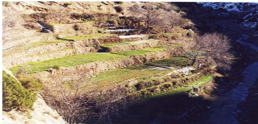
Figure 9. Terrasses construites sur berge et consolidées par des murs en pierres sèches.
