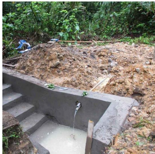
Figure 1. 16. Schéma d'aménagement simple d'une source
