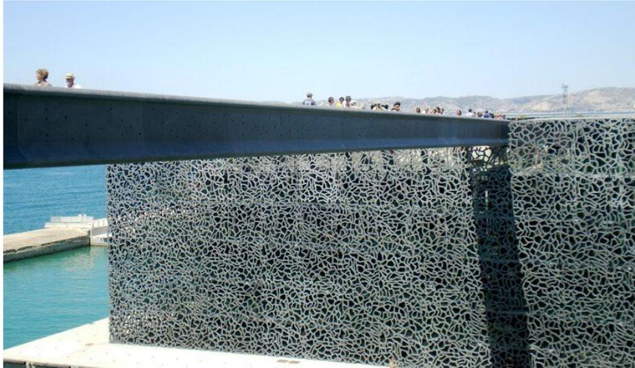
**Figure II.2.** Exemple de Passerelle des Anges (France) en BFUP
