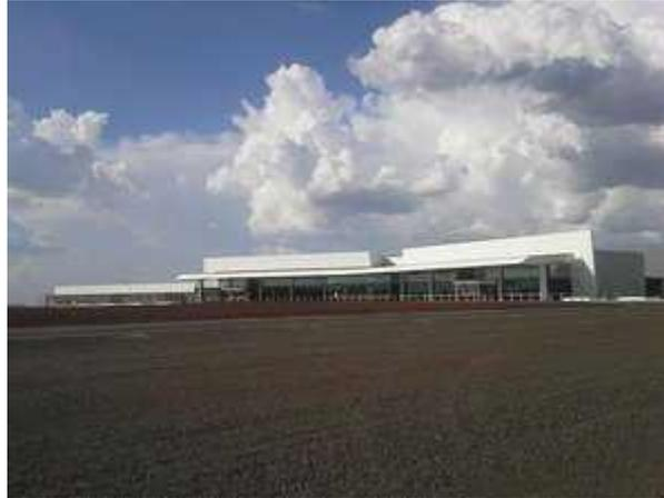
**Figure II.8.** Le nouvel aéroport « Brisbane West Wellcamp » en Australieréalisé avec un béton géopolymère.
