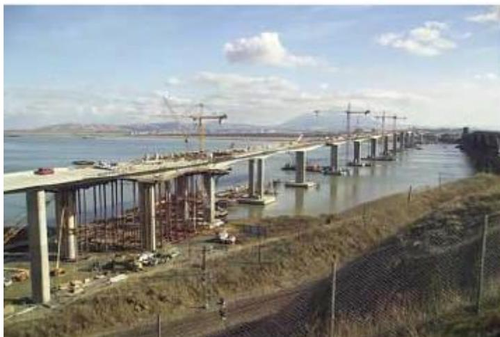
**Figure II.7.** Pont Benicia-Martinez avec du métakaolin dans la formulation du béton (Californie, USA, 2007)
