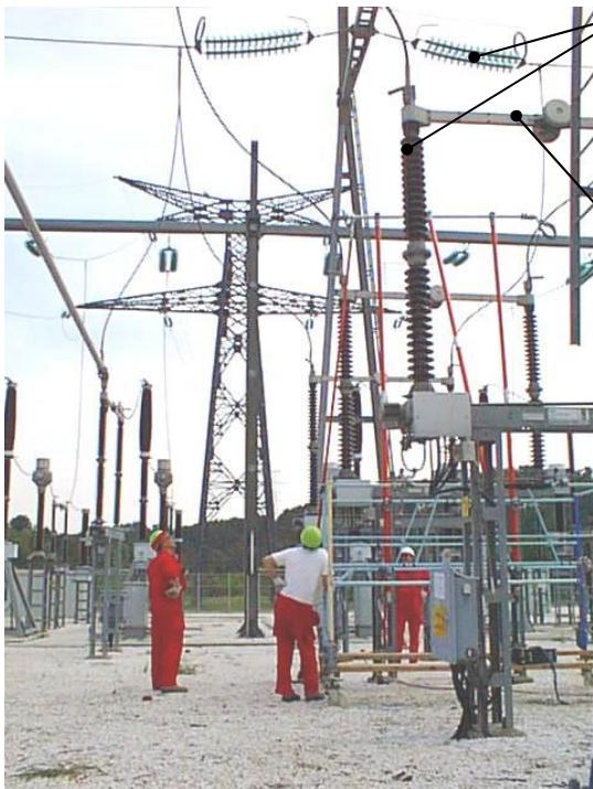
---- Sectionneur 63 kV ----
