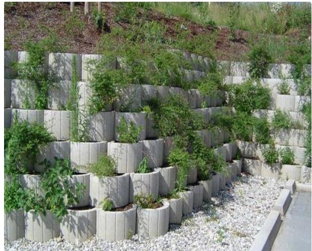
Mur poids en éléments préfabriqués
