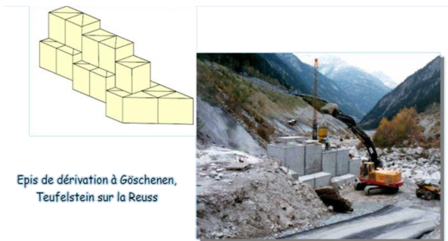
Fig. IV.7: Epis en béton
