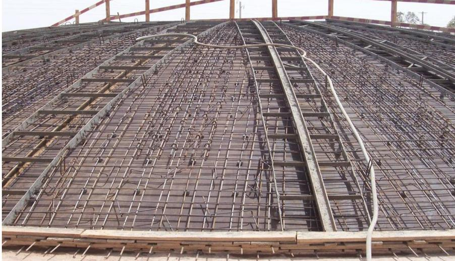
Exemple d'un ferrailage d'une coupole
