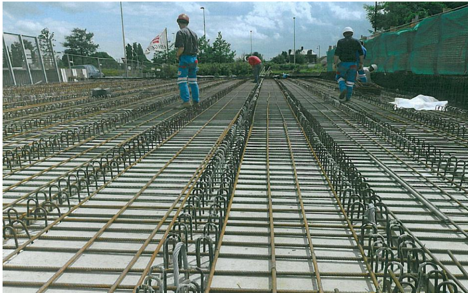
Figure 15 : Hourdis ferrailé
