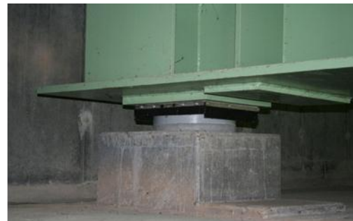
Figure 3 : Appareil d'appui
