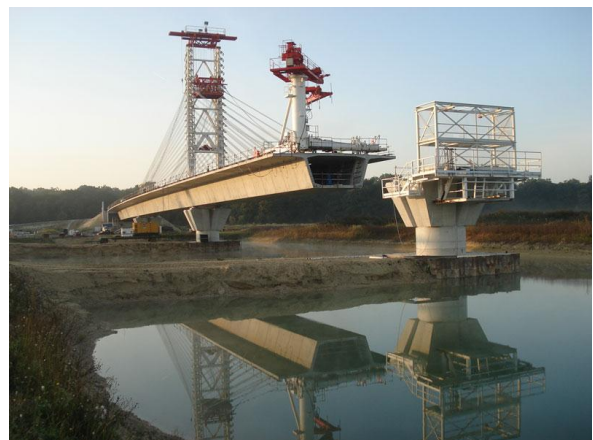
Figure 21 : Pont construit par encorbellement successif
