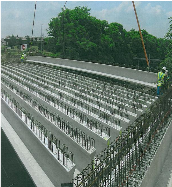
Figure 12 : pose par grue
