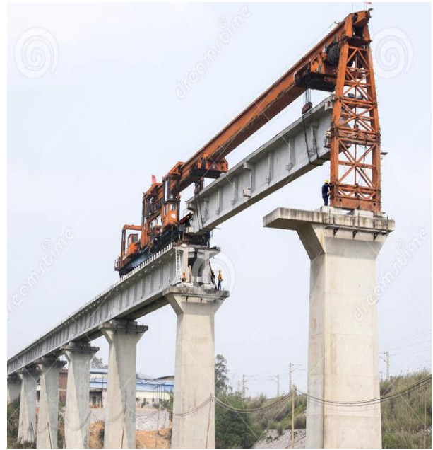
Figure 13 : pose par lançage
