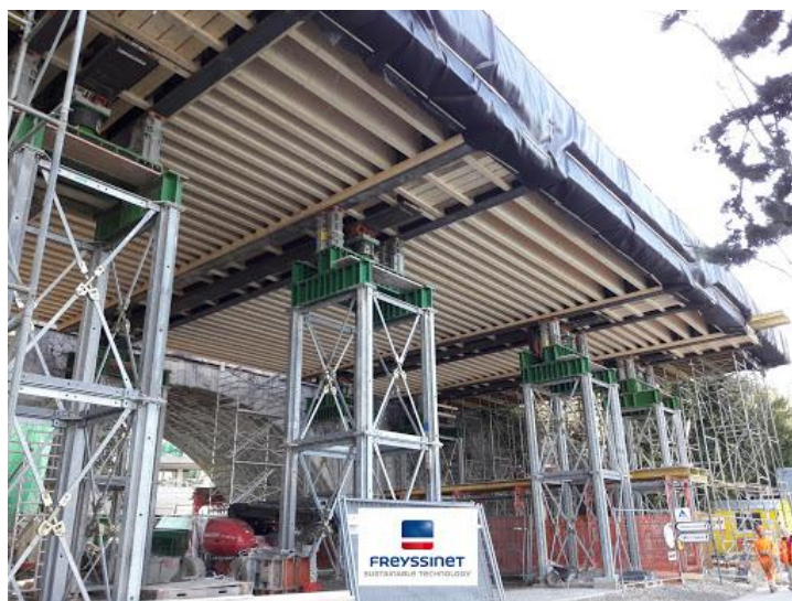
Figure 12 : Tablier coulé sur un étaieiment
