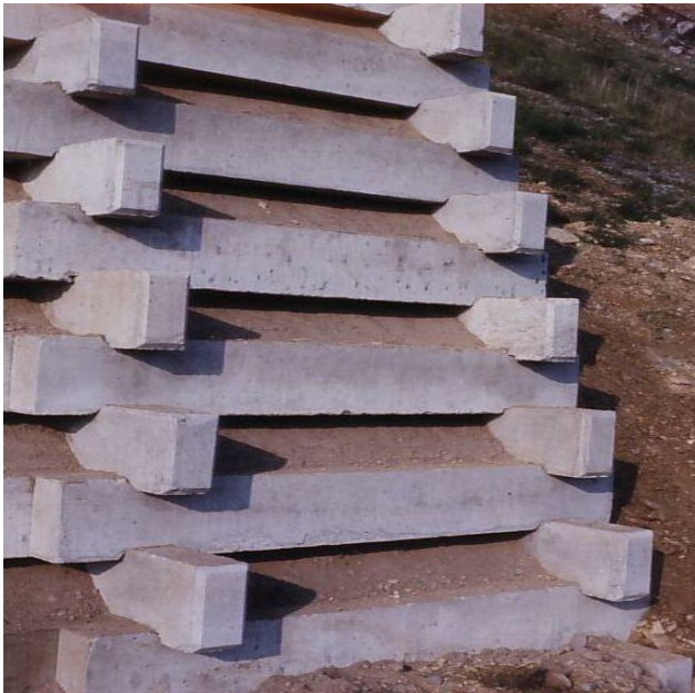
Mur poids en éléments préfabriqués
