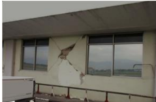
Mode de fonctionnement d'un mur de contreventement
