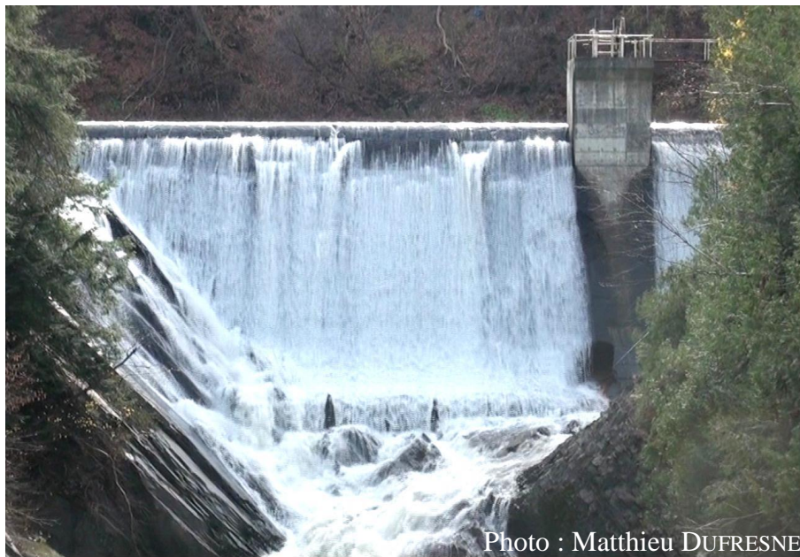
Figure 4. Eau blanche sur le coursier du barrage de Coaticook (Canada).
