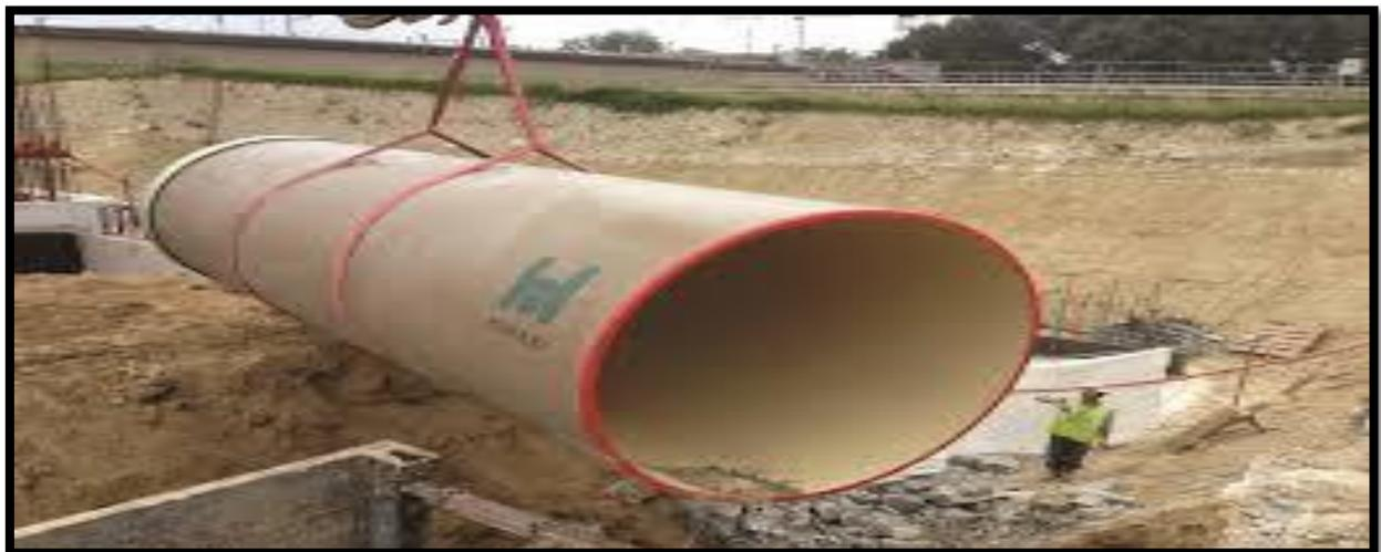
**Figure 9 :** Tuyau en PRV
