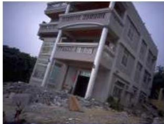
Figure 4.2 : Immeuble sur faille Seisme de Chi-Chi (Taïwan 1999) [13].
