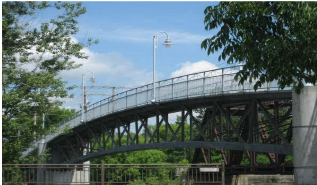
Figure IV.8. Passerelle piétonnière de Sherbrooke réalisée en 1997.
