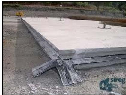
**Figure VII.4.** Joint de construction
