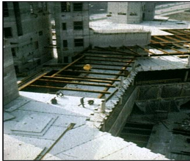
Figure IV.7. Exemple de plancher préfabriqué.
