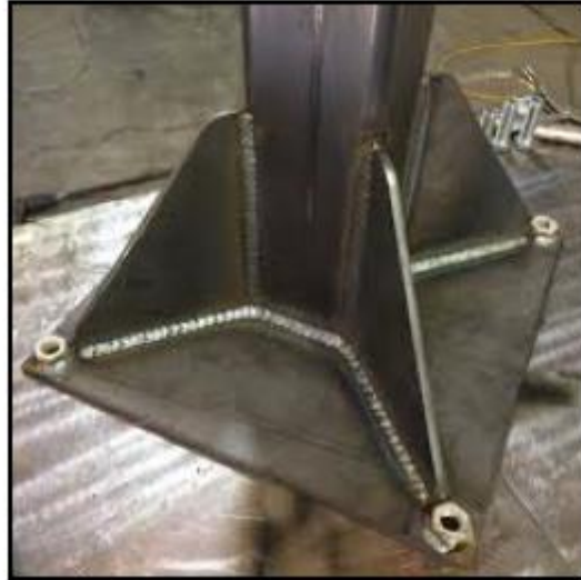
Figure IV.20. Soudure de la base d'un poteau
