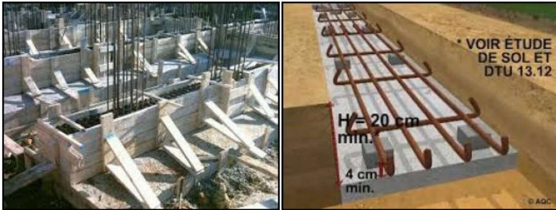
Figure III.25. Coffrage et ferrailage d'une semelle filante
