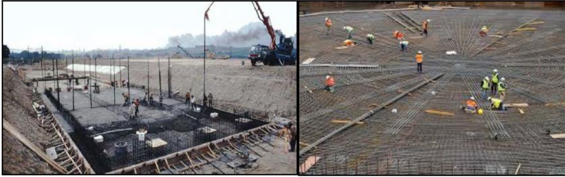
Figure III.27. Ferrailage et bétonnage de Radiers
