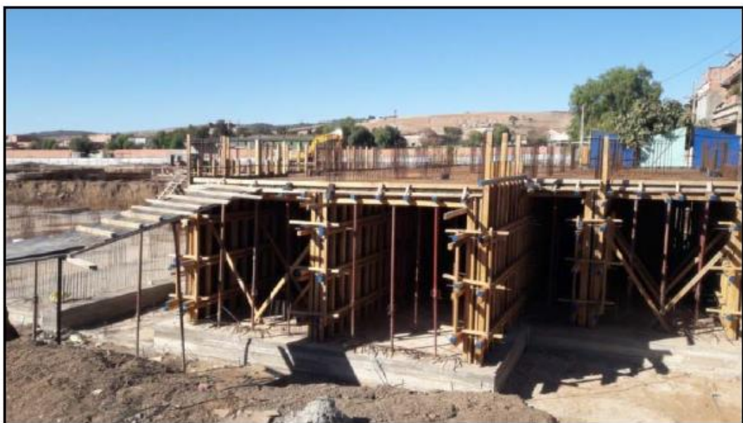
Figure III.51. Eléments de coffrage en bois (Coffrage tunnel)
