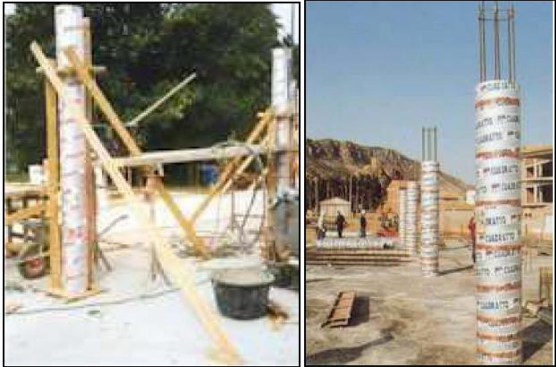
Figure III.42. Coffrage perdu en carton pour poteaux circulaires
