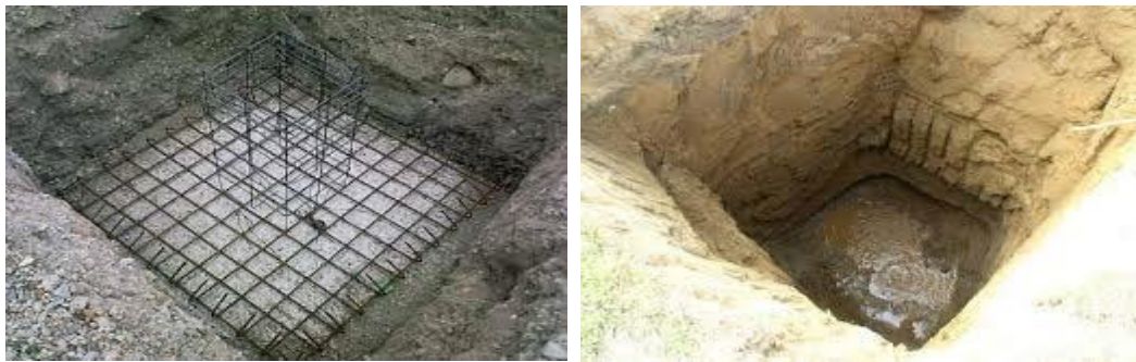
Figure II.5. Fouille en puits
