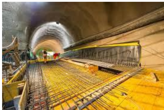
Figure II.6. Fouille en galerie
