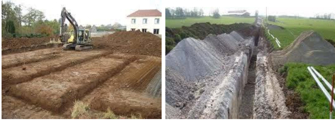
Figure II .4. Fouille en tranchée
