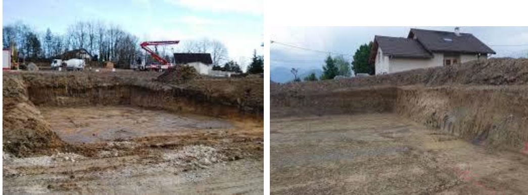
Figure II .3. Fouille en pleine masse
