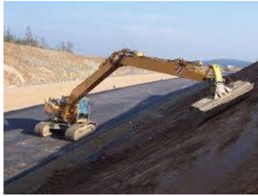
Figure II.8. Talutage en déblais
