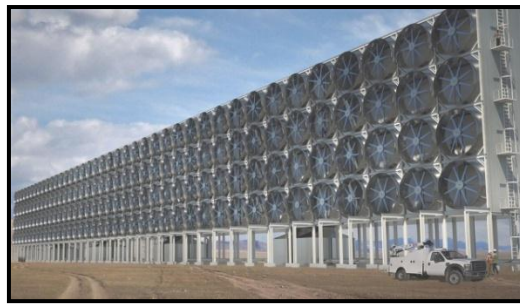
Figure 01. Capture du CO 2 (Filtration par ventilation)
