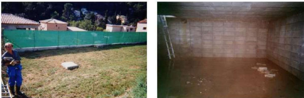
**Figure 46 :** A droite, un bassin de rétention enterré d'un immeuble d'un volume de 60 m<sup>3</sup>, à gauche un bassin enterré d'une villa de 25 m<sup>3</sup>.
