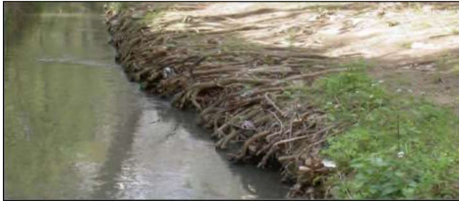
Figure 5 : Aménagement des berges de l'oued contre le glissement
