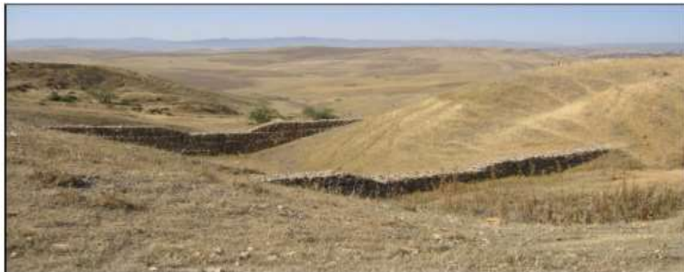
Figure 7 : Correction torrentielle dans la région de Tlemcen
