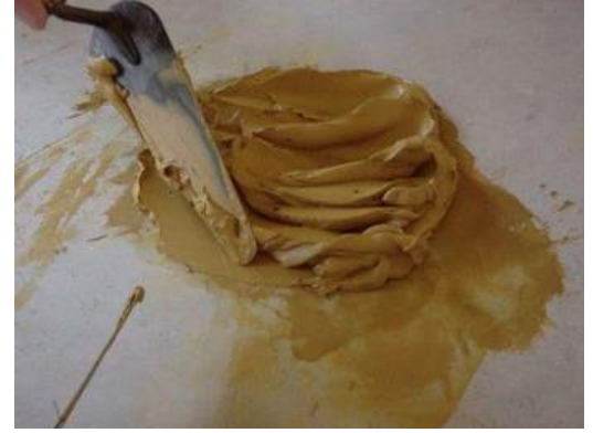
Homogénéisation par malaxage à la truelle
