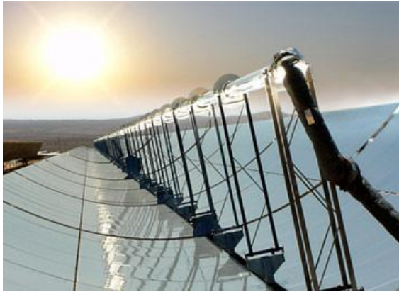
Centrale solaire à collecteurs cylindro-paraboliques
