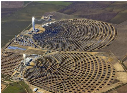
Plateforme solaire Abengoa, à Séville (Espagne)
