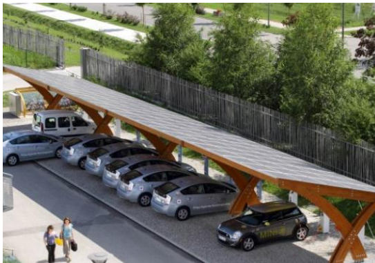
Parking solaire pour véhicules Electriques
