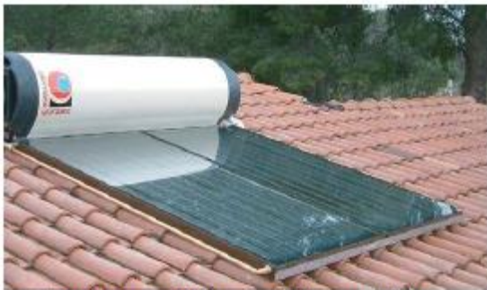
Photo : chauffe-eau solaire monobloc
