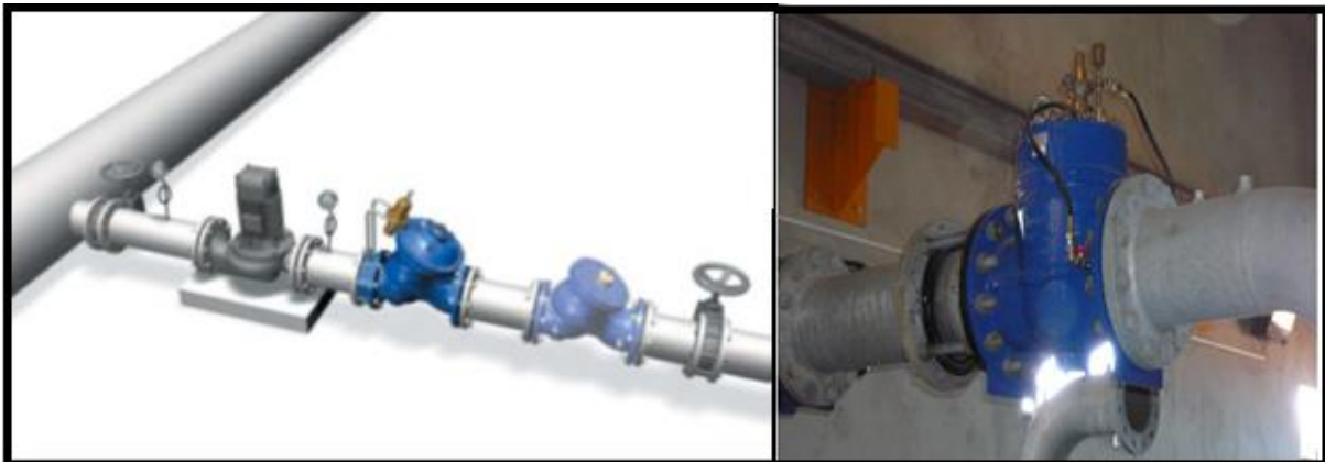
Figure 28 : Exemple d'une vanne de régulation de débit
