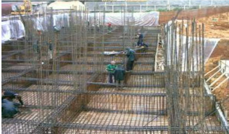
Figure 8 : exemple de ferrailage de radier nervuré
