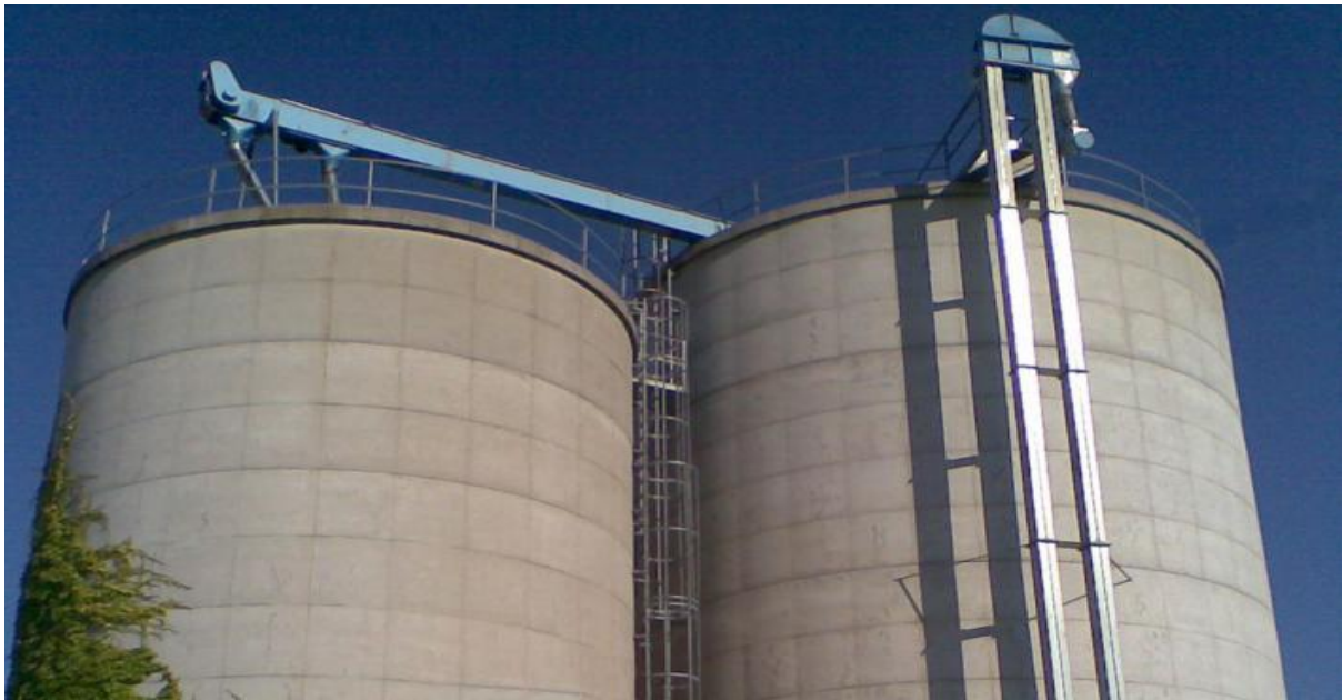
Figure 1 : silos en Béton armé
