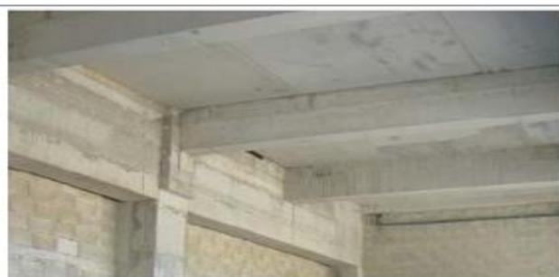
Figure 03 : d. dalle unidirectionnelle
