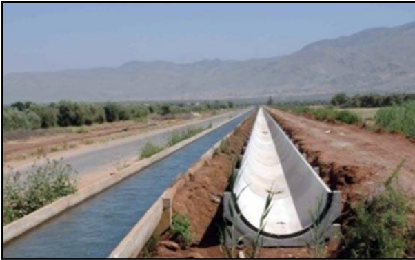
Figure IV.2. Canal à surface libre
